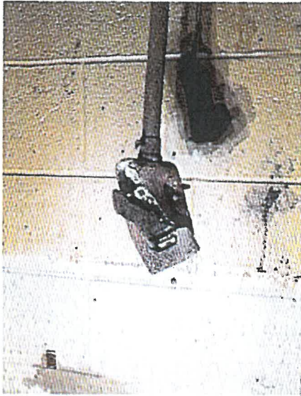
Acid Room Conduits
